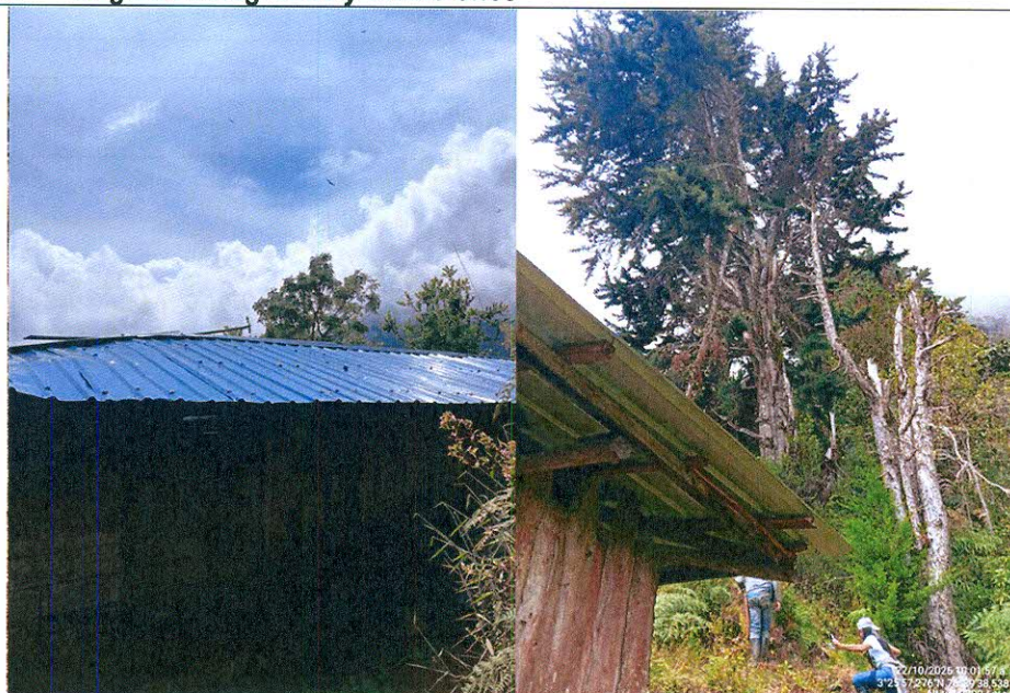
Figura 1. Fotografías en donde se evidencia el estado actual de la vivienda, se observa madera en deterioro en el piso, paredes y en la estructura que soporta el techo.
